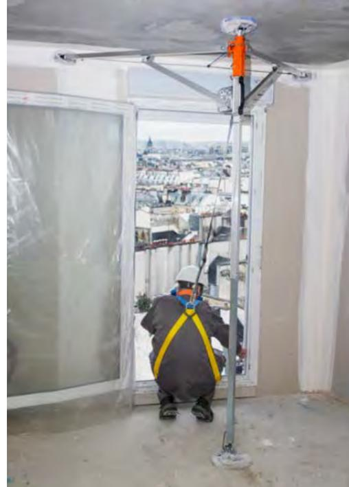
**LE SYSTÈME D'ANCRAGE MOBILE SYAM** est un point d'ancrage transportable qui permet de sécuriser les interventions au bord du vide.
