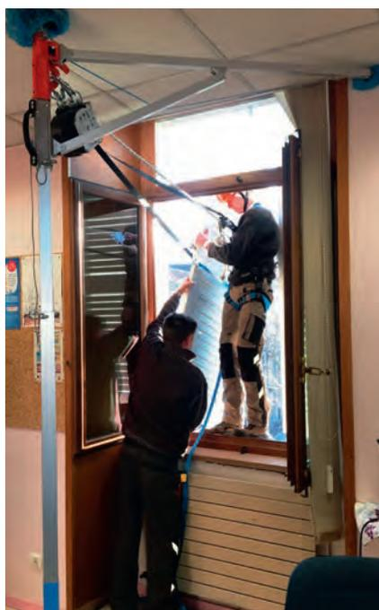
Lors de la dépose d'un volet battant, le SYAM permet de sécuriser aussi bien l'opérateur que le volet (évitant qu'il ne tombe en contrebas).
