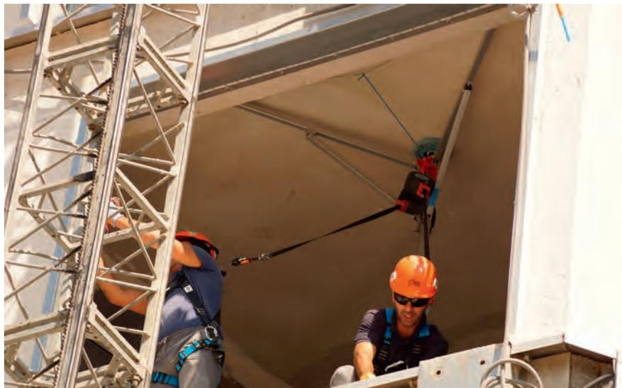
Sur chantier neuf, le SYAM permet de se sécuriser lorsque les protections collectives ont été ôtées.
